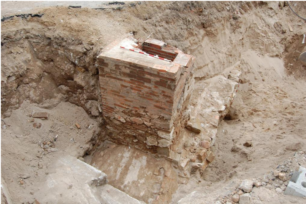
Foto 7. Vista del col·lector i pou de registre des del nord.
