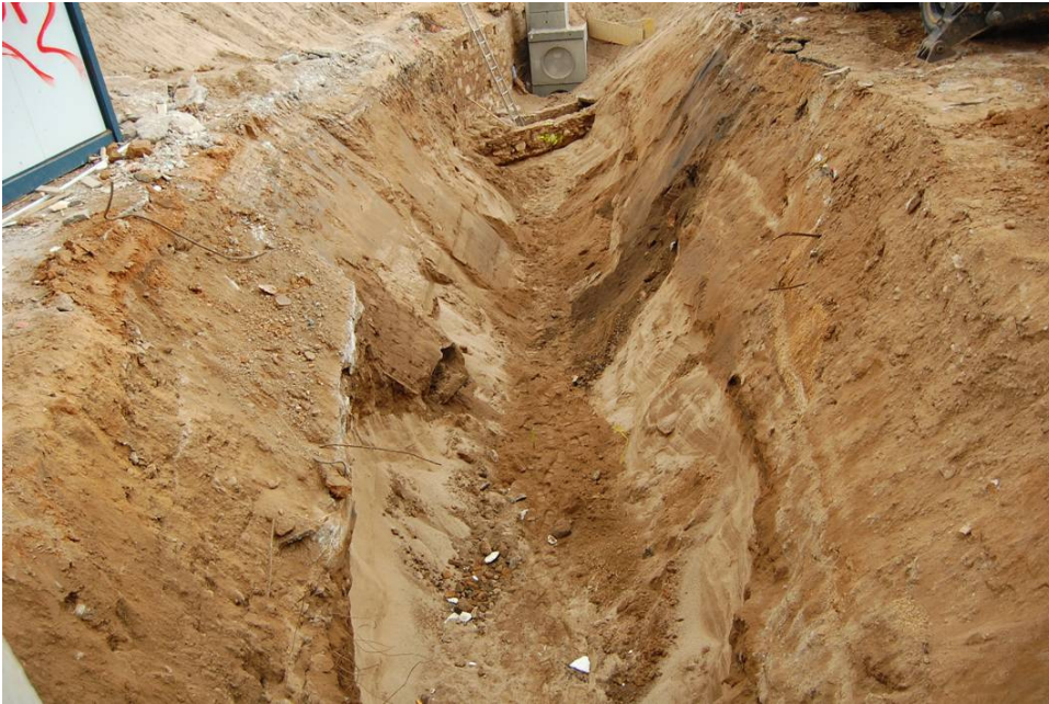
Foto 3. Vista parcial de la rasa amb la canalització UE 101, 102 i 103 al fons.
