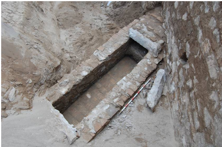
Foto 2. Vista de la canalització UE 101 i 102 i el paviment UE 103.
