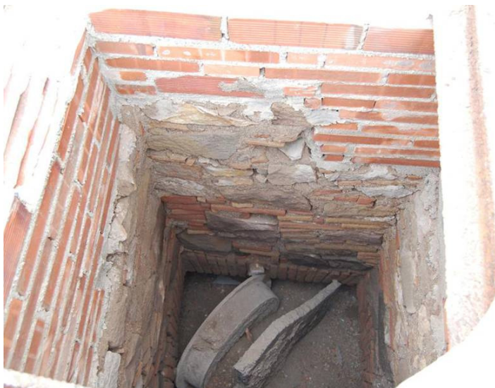
Foto 6. Vista de l'interior del pou de registre UE 109,110.
