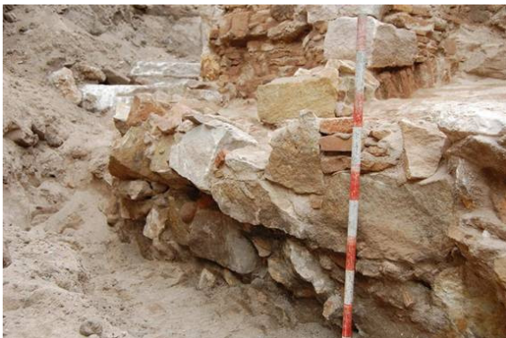
Foto 5. detall de l'aparell constructiu del mur UE 108.
