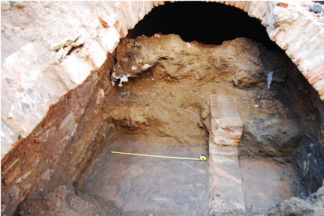
Foto 8. Vista de l'interior del col·lector, es pot veure el paviment UE 112 i el petit mur UE 113.
